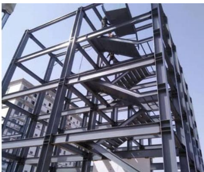
Рис. 4. – Здание с обыкновенным рамным стальным каркасом
